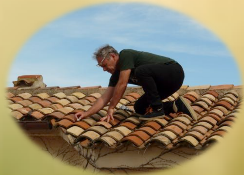
Correction d'une pente de toit en Corse
